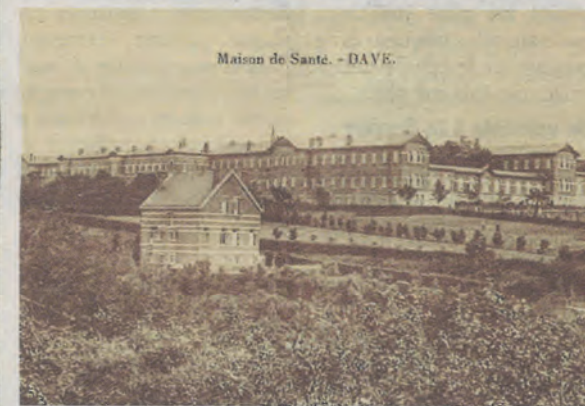
Les bâtiments de l'aile ouest, qui caractérisaient la présence de Saint-Martin dans le paysage depuis la vallée de la Meuse, ont été démolis en 2000.
